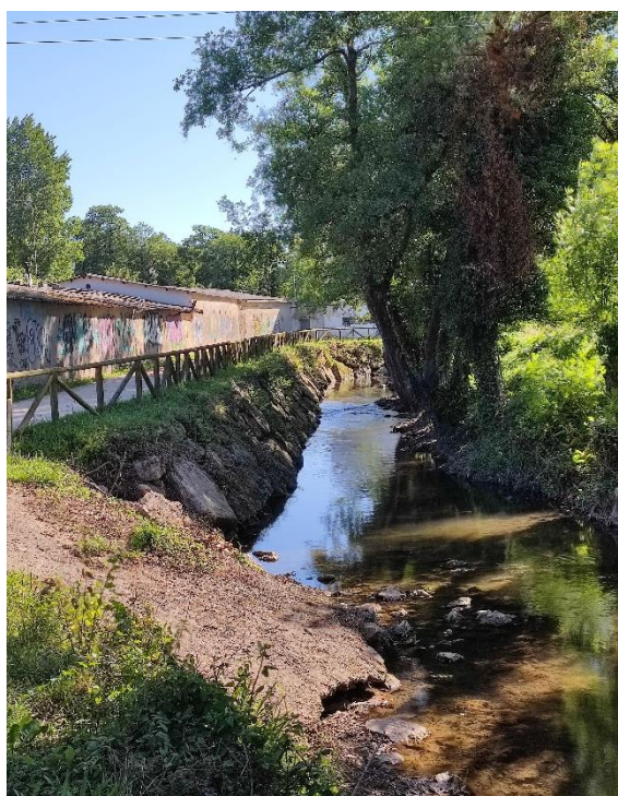
Foto 12. (920-21-31) Arroyo Meredal en la zona próxima a la confluencia con el arroyo Llantones, viéndose una bajada cementada al cauce y ausencia de bosque en la escollera. Coordenadas ETRS 89, Huso 30T, X: 285912 Y: 4820202.
