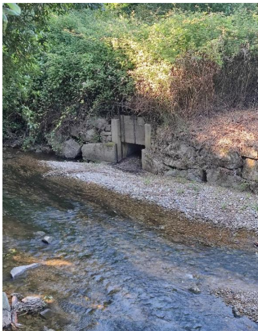
Foto 2. (920-20-09) Compuerta de canal de derivación situada en la margen derecha que aporta agua al humedal ornitológico Alfredo Noval, colmatado por aporte de sedimentos en avenidas. Coordenadas ETRS 89, Huso 30T, X:285556 Y:4820800.
