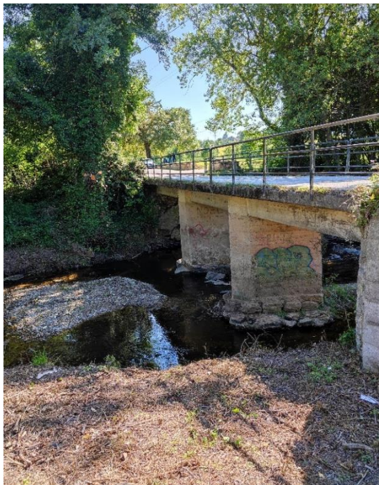
Foto 1. (920-21-08) Puente sobre el río Piles que da acceso al Parque de Granda. Presencia de sedimentación que evidencia el efecto azud. Coordenadas ETRS 89, Huso 30T, X:285565 Y:4820776.
